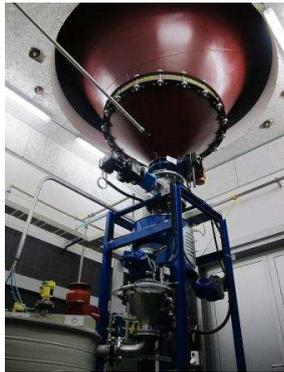
Der Silo mit der Pulveraktivkohle vom unterirdischen Technikraum aus gesehen. Unterhalb des Silos befindet sich der Mischer für die Kohle-Wasser-Suspension, die in die Reinigungsbecken gegeben wird.
