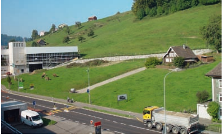
Die vorgesehene Bauparzelle an der St. Gallerstrasse.
