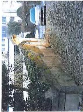
Abb. 52: Seitliche Stützmauer mit Sandsteinabdeckungen beim erhöhten Gartenraum.
