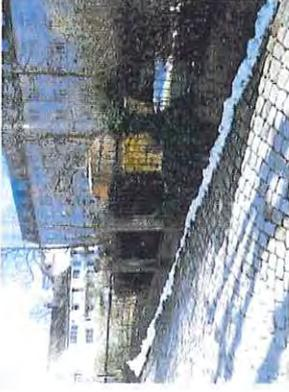
Abb. 67: Spätklassizistische Einzäunung aus Sandsteinsockelmauer mit Gussseisen-Staketenzaun.
