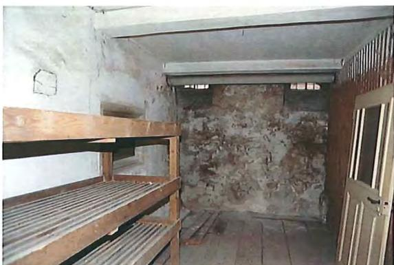
Abb. 84: Kellergeschoss, Raum -1.05. Blick gegen Süden. Das linke Fenster befindet sich zu nahe an der Wand und wurde nachträglich (1811-1830) eingebaut, um eine Fenstersymmetrie zu erhalten.
