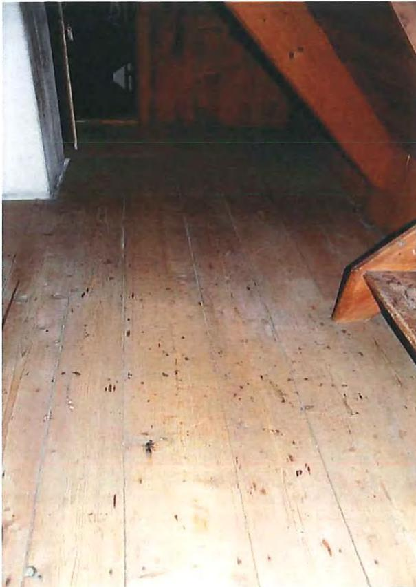
Abb. 182: 1. Dachgeschoss, Abseiten Raum 2.08. Riemenboden mit drahtgezogene Nägeln.
