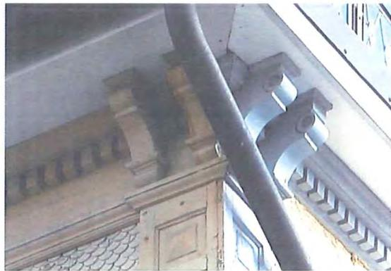
Abb. 69: Grosser Brühlhof, nordwestliche Ecke der Nordfassade mit umlaufendem Zahnfries und Konsolen. Foto: Ibid 2013.
