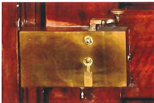
Abb. 34: Erdgeschoss, Raum 0.01, Detail des Kastenschlosses (1. H. 19. Jh.).
