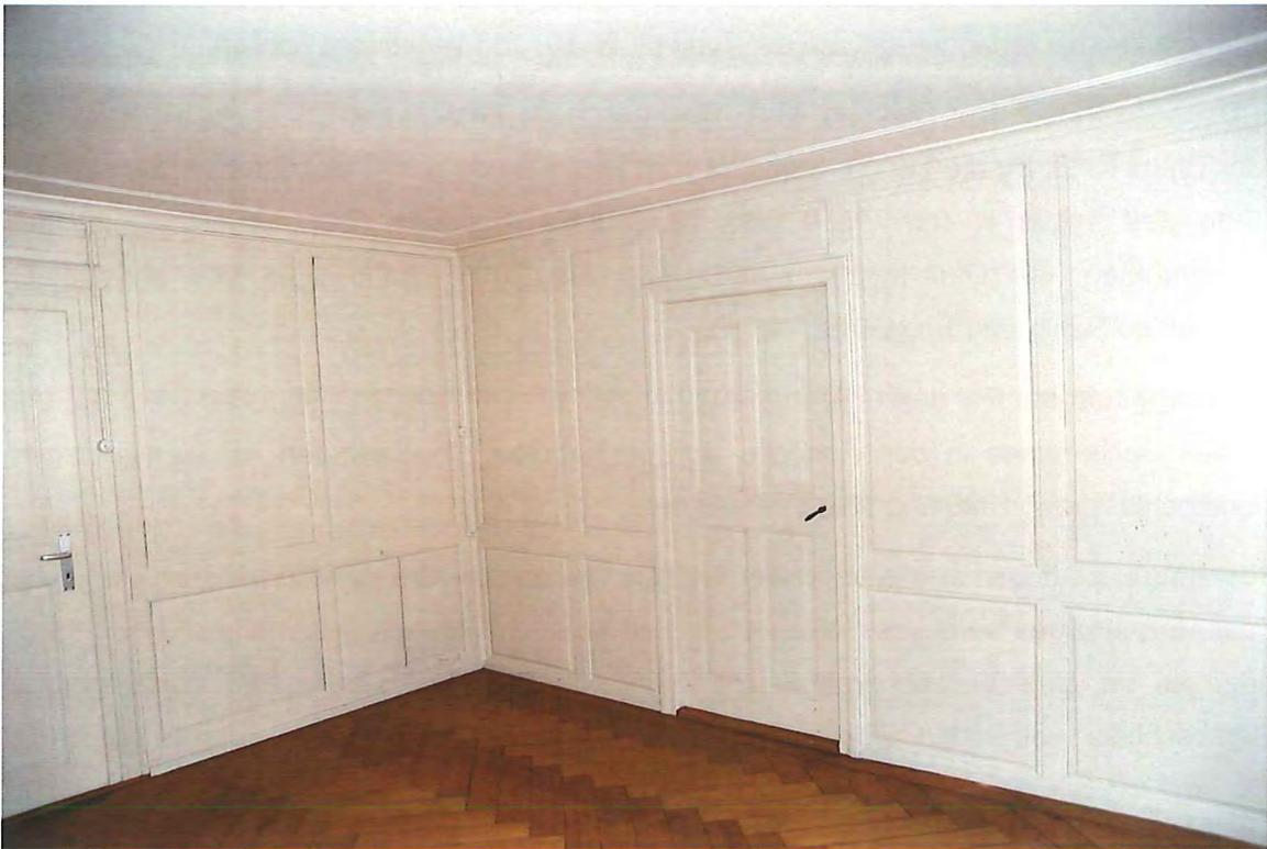
Abb. 48: Erdgeschoss, Raum 0.11, zweizoniges Feldertäfer Typ A (1. H. 19. Jh.).
