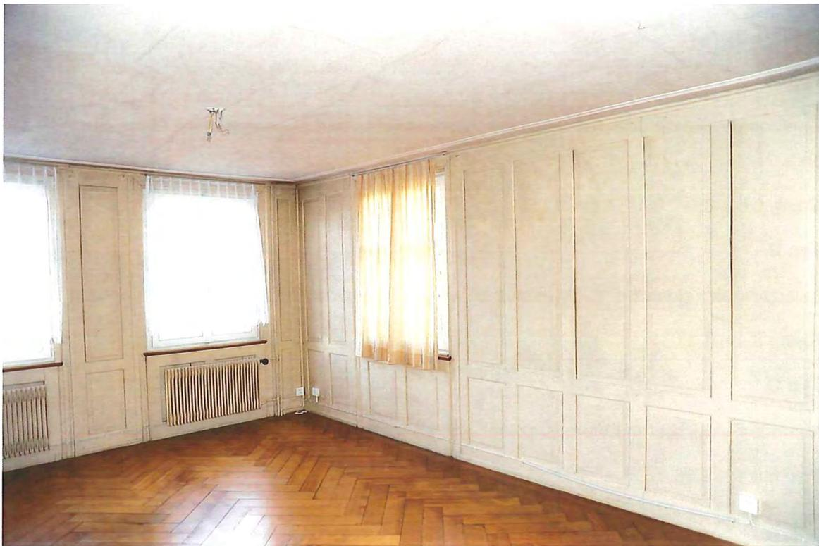
Abb. 49: Erdgeschoss, Raum 0.14, zweizoniges Feldertäfer mit Viertelstabfries, Typ B (1880-1883).
