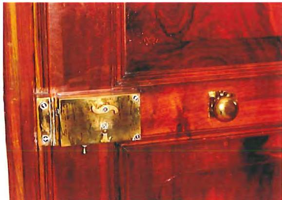
Abb. 36: 1. Obergeschoss, Raum 1.13, Vorderseite der Zimmertür, Detail mit Türknauf und Kastenschloss (1805).
