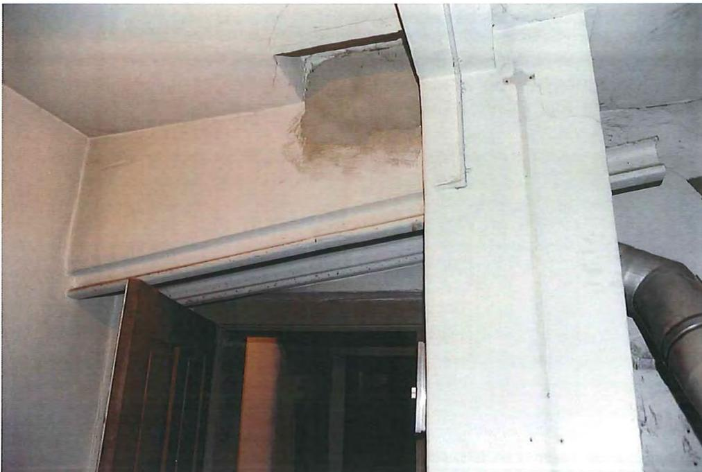
Abb. 86: Kellergeschoss, Raum -1.06. Nachträglich eingebauter Unterzug aus Eisenbahnschienen (2. H. 19. Jh./frühes 20. Jh.).
