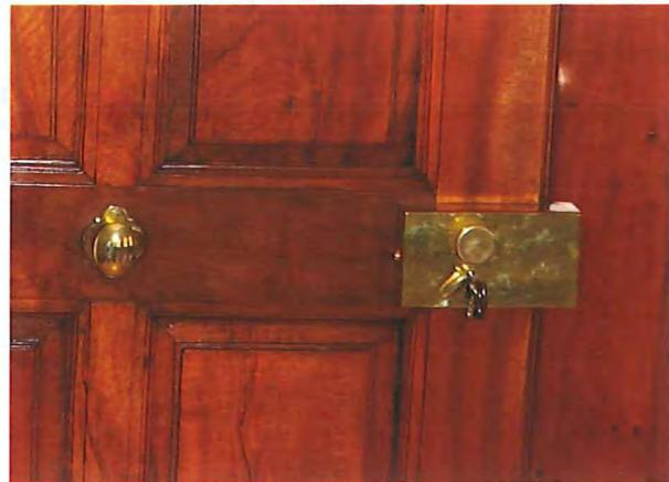
Abb. 41: 1. Obergeschoss, Raum 1.05, Rückseite der Zimmertür. Kastenschloss und Türknauf (1. H. 19. Jh.).
