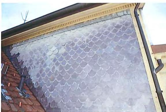
Abb. 66: Grosser Brühlhof, Ostwand des nördlichen Quergiebel mit Schieferplattenschirm. Foto: Ibid 2013.
