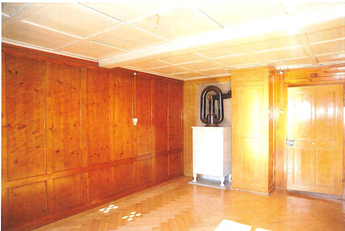
Abb. 51: 1. Dachgeschoss, Raum 2.07, zweizoniges Feldertäfer mit Viertelstabfries, Typ D (1880-83).
