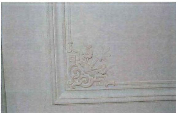
Abb. 138: 1. Obergeschoss, Raum 1.05. Eckkartusche der Deckenstuckatur.
