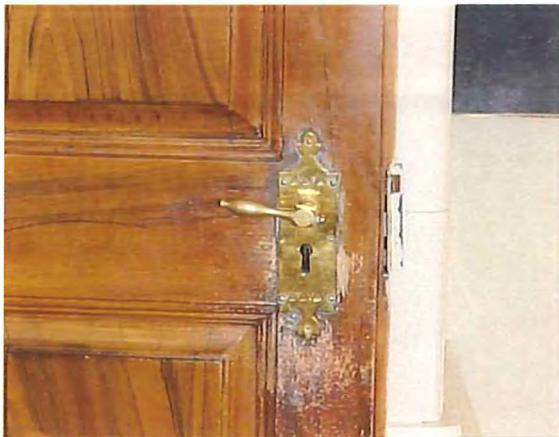
Abb. 40: 1. Obergeschoss, Raum 1.02, Vorderseite der Zimmertür mit Empire-Türschild und Drücker (ersetzt) (1. H. 19. Jh.).
