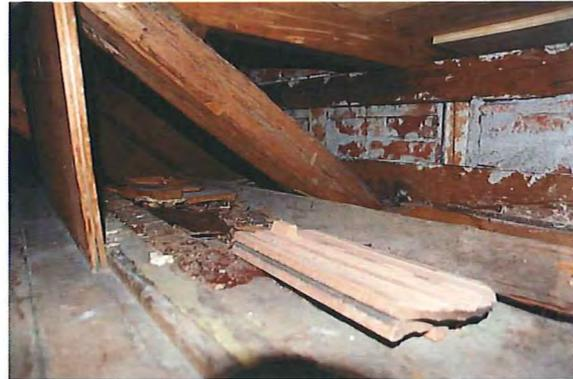
Abb. 181: 1. Dachgeschoss, Abseiten Raum 2.09. Blick gegen Sparren der nördlichen Dachfläche mit Aufschieblingen über Kniewand.
