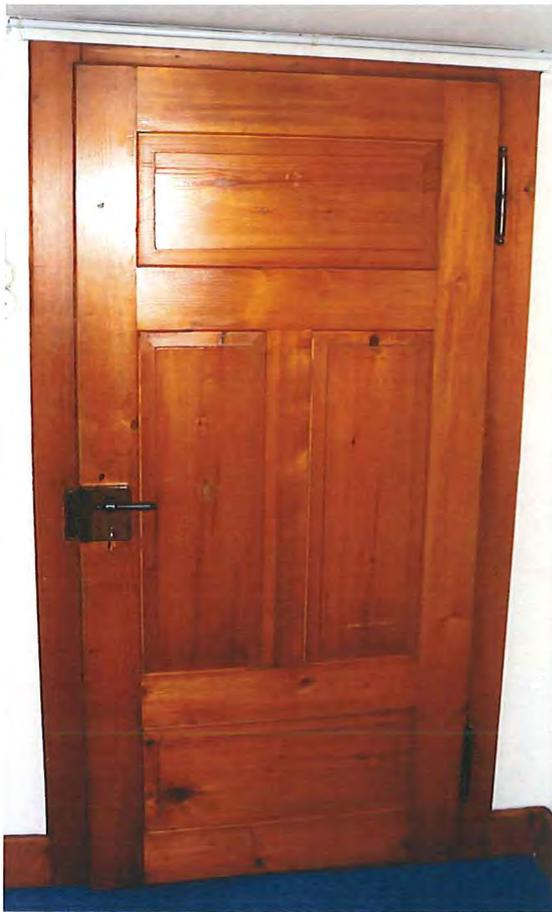
Abb. 46: 2. Dachgeschoss, Raum 3.01, Rückseite der Zimmertür (Typ L) (4. V. 19. Jh.).
