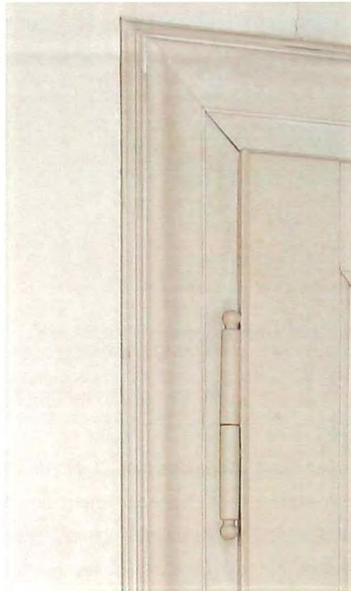
Abb. 43: 1. Obergeschoss, Raum 1.07, Vorderseite der Zimmertür mit schwacher profilierter Türeinfassung und Fischband mit kugelförmigem Zierabschluss (2. H. 19. Jh.).
