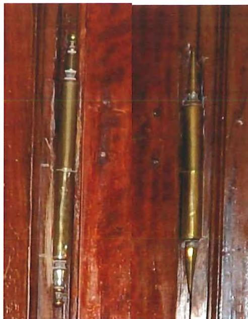
Abb. 33: Erdgeschoss, Raum 0.01, Zwei Varianten von Fischbändern (tropfenförmiger und spitz zulaufender Abschluss) (1. H. 19. Jh.).
