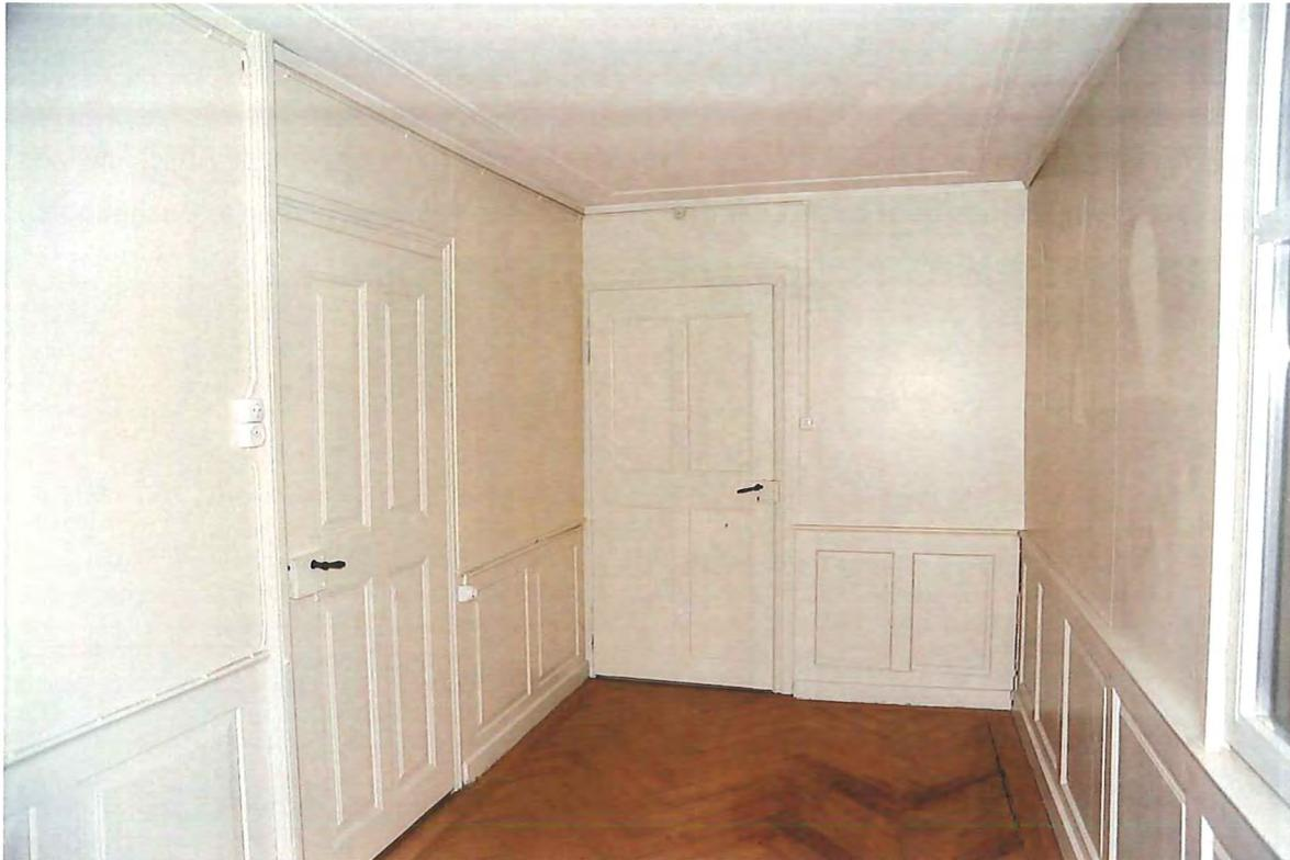
Abb. 50: Erdgeschoss, Raum 0.12, Lambris-Feldertäfer mit Viertelstabfries, Typ C (1880-83).
