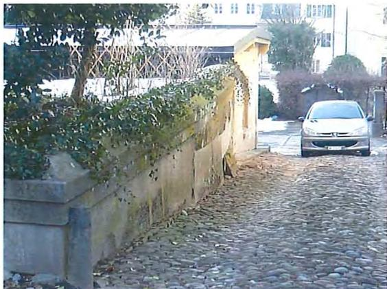
Abb. 227: Seitliche Stützmauer mit Sandsteinabdeckungen beim erhöhten Gartenraum.
