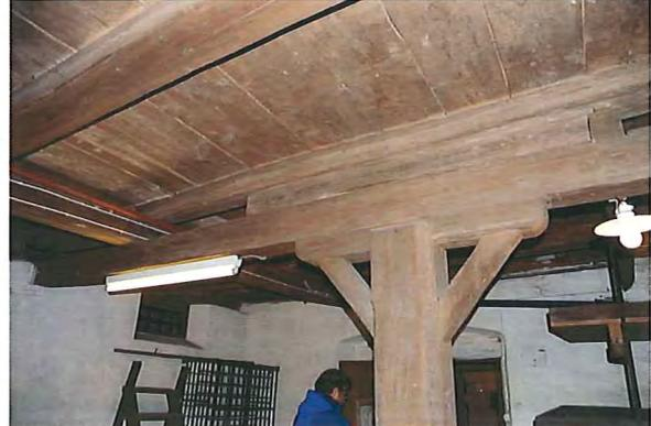
Abb. 80: Kellergeschoss, Raum -1.03. Deckenbalkenunterzug.
