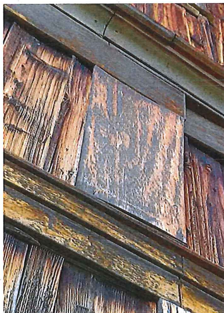
Fassadenreparaturen sind unsachgemässe Flickarbeiten mit Pavatex und Sperrholz.
