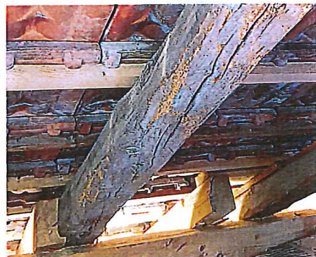
Der Dachstuhl hat im angebauten Scheunenteil kaum ursprüngliche Substanz und ist vielerorts unsachgemäss erweitert und verstärkt. Ein neues Dach wäre generell sinnvoll im ganzen Anbauteil. Dämmung und Eindeckung am Hauptdach Ersetzen und Ergänzen (nur teilweise vorhanden).
