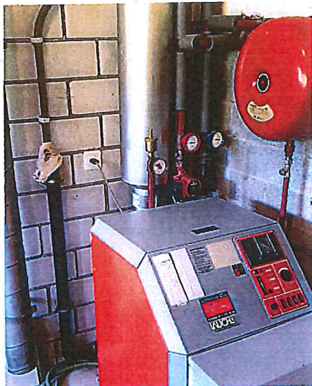
Ölheizung, funktionstüchtig, erhalten möglich, auch in niedrigerem Keller (h 200) möglich
