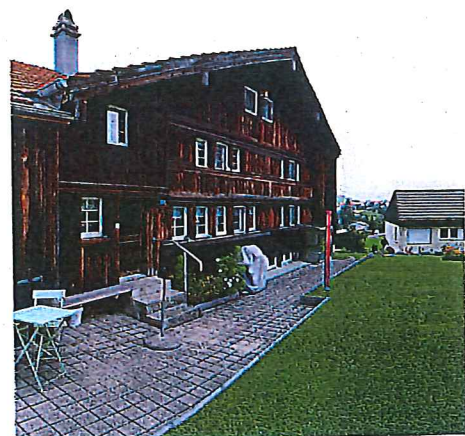
Zementplattenbeläge im südlichen Garten stören die typische Erscheinung, entsprechen aber den Ansprüchen an die Nutzung der Aussenplätze.
