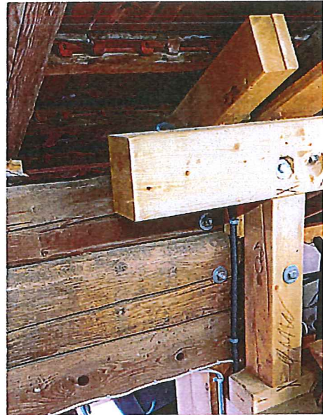
Der Dachstuhl hat im angebauten Scheunenteil kaum ursprüngliche Substanz und ist vielerorts unsachgemäss erweitert und verstärkt. Ein neues Dach wäre generell sinnvoll im ganzen Anbauteil. Dämmung und Eindeckung am Hauptdach Ersetzen und Ergänzen (nur teilweise vorhanden).
