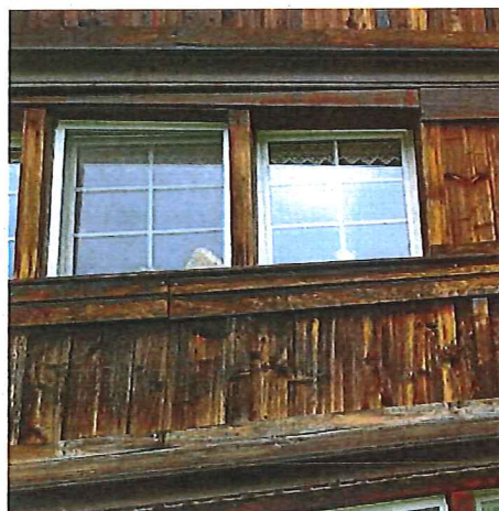
Fassadenreparaturen sind unsachgemässe Flickarbeiten mit Pavatex und Sperrholz.
