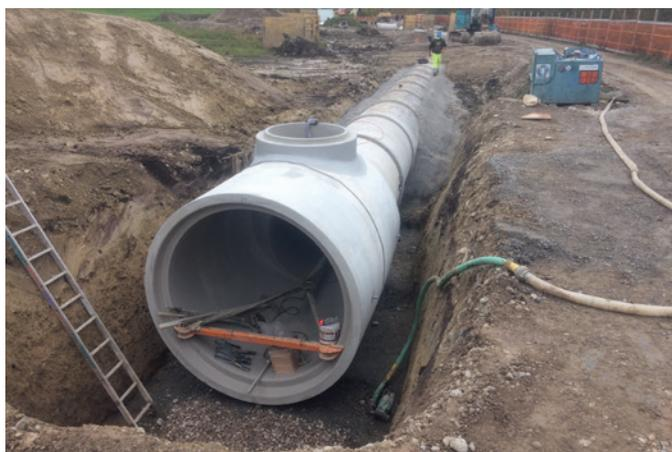
**Mit Retentionsstaukanälen, hier in der Nordhalde, kann Regenwasser verzögert abgeleitet werden.**
