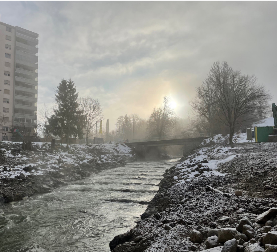
Die neu gebaute Rampe im Herbst 2023. Dank dem Abbau der alten Schwelle können Fische in der Glatt wieder von der Mündung bis in den Oberlauf gelangen.
