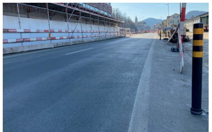
Die provisorisch instand gesetzte Güterstrasse.
