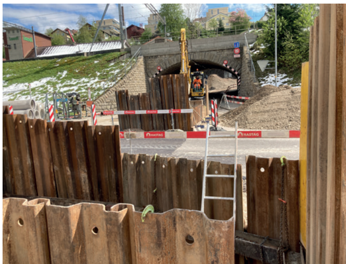
Das Foto zeigt die grösseren Grabarbeiten an der St.Gallerstrasse vom vergangenen Jahr.
