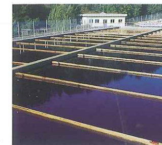
9 Zwischen- und Nachklärbecken mit Schlammräumanlage
