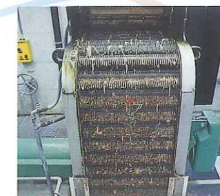
5 Rechenanlage zur Entfernung grober Schmutzstoffe
