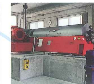
7 Schlamm-Entwässerungsanlage
