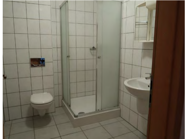
Dusche-WC-Lav. / 2-ZW im EG
