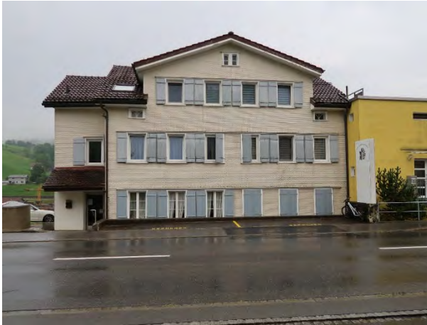
Ansicht von Nordwesten / «Altbau» mit Anbau
