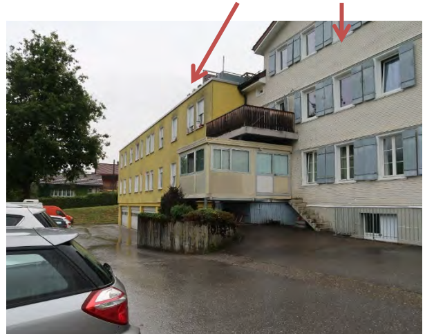
Ansicht von Osten / «Neubau» und «Altbau»
