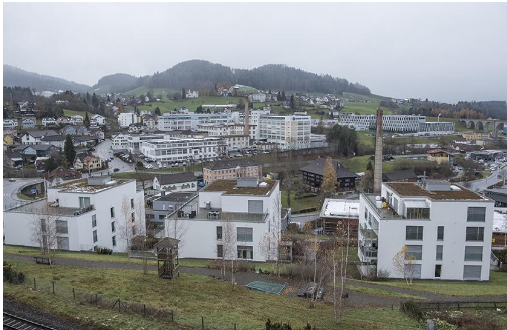
Industriegebiet von der Grub am westlichen Rand des Ortskerns aus gesehen
