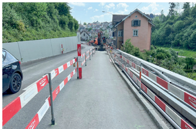
Die Stützmauern (berg- und talseitig) werden ebenso saniert wie der Belag und das Trottoir.
