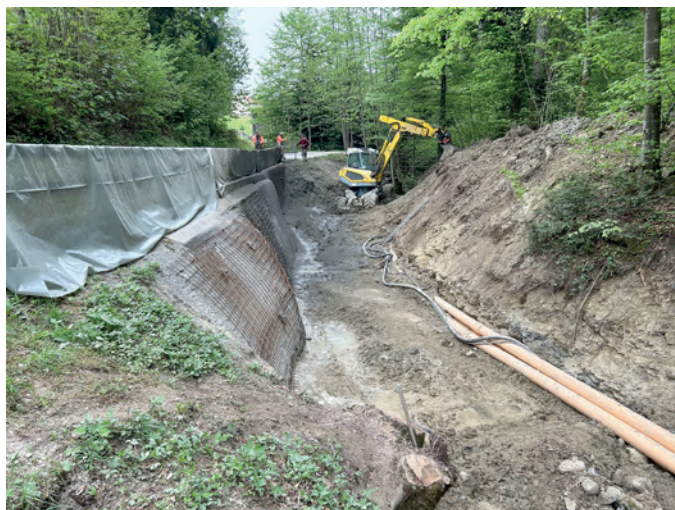
Das Bachbett während der Bauarbeiten. Das Wasser wurde solange durch Rohre geleitet.
