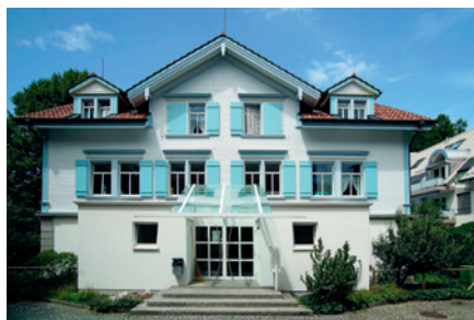
Schulhaus Landhaus Ost
