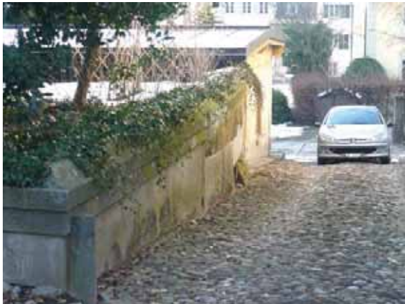
Abb. 52: Seitliche Stützmauer mit Sandsteinabdeckungen beim erhöhten Gartenraum.
