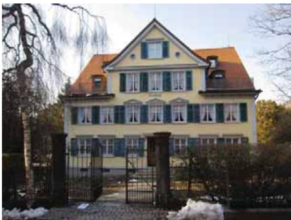
Abb. 36: Grosser Brühlhof, Ansicht von Süden. Foto: Ibid 2011.
