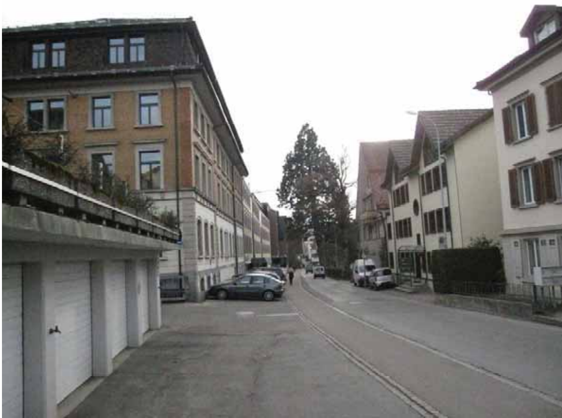
Abb. 33: Oberdorfstrasse, von Osten. Foto: Ibid 2011.
