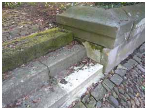
Abb. 51: Detail Mauerabdeckung und Treppenstufen zum erhöhten Gartenraum.
