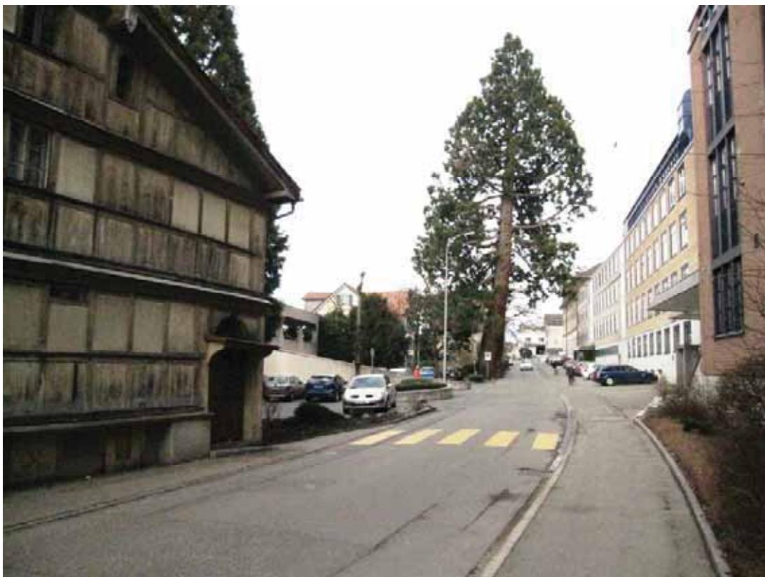
Abb. 32: Herisau, Oberdorfstrasse, von Westen. Foto: Ibid 2011.
