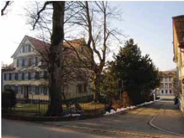
Abb. 38: Grosser Brühlhof, Ansicht von Südosten. Foto: Ibid 2011.
