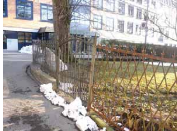
Abb. 59: Südliches Zugangs-Tor an der Gartenstrasse.
