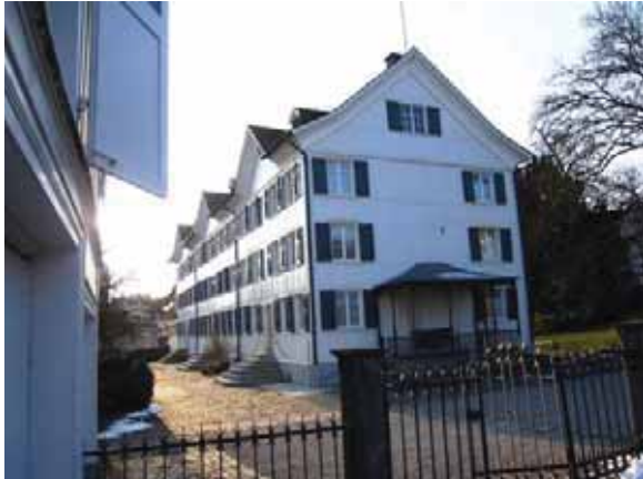
Abb. 62: Sonnenhof, südliche Trauf- und östliche Giebelfassade. Ansicht von Südosten.
