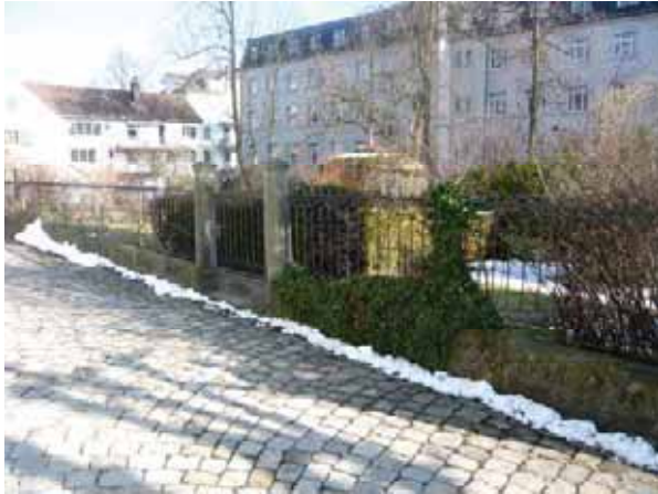
Abb. 67: Spätklassizistische Einzäunung aus Sandstein-Sockelmauer mit Gusseisen-Staketenzaun.
